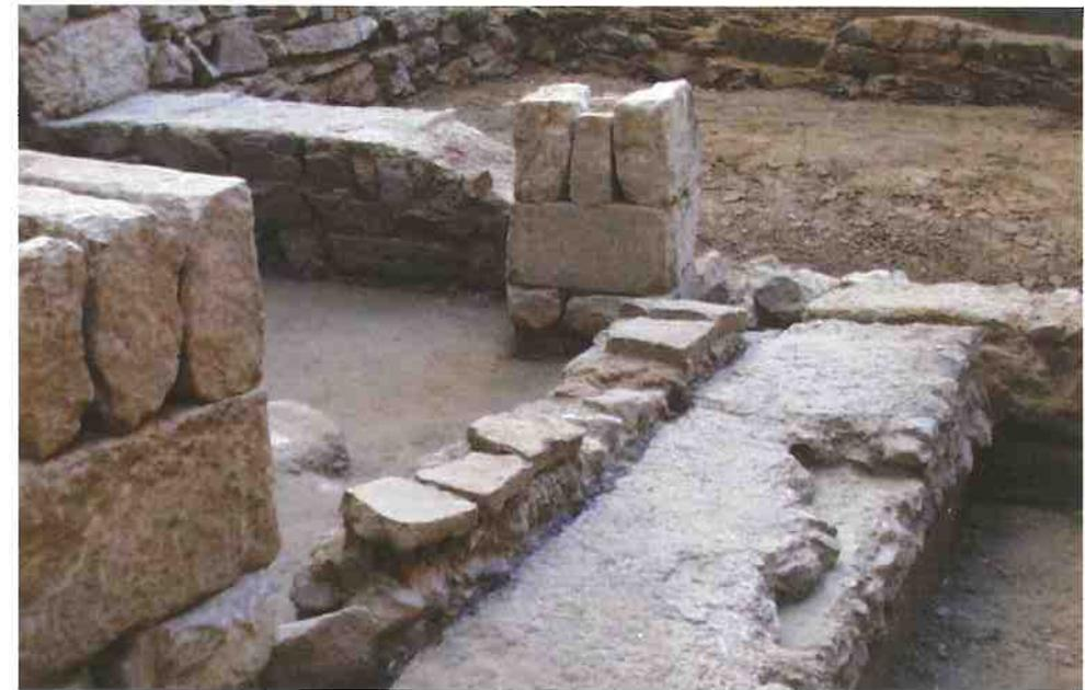
*Detalle de los pilares fabricados con sillares de piedra arenisca, en la casa ubicada en la calle Desamparados*
